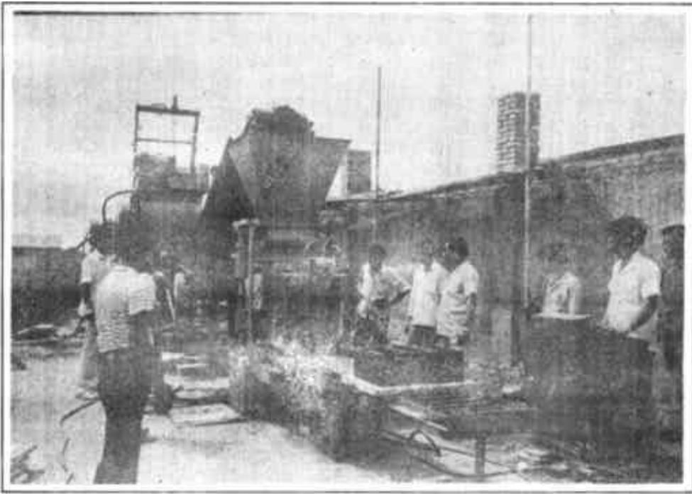
△市建材工业公司空心砌块成型机正在工作
